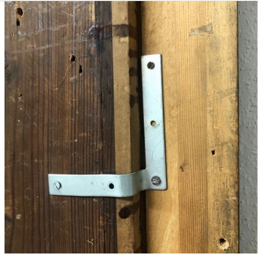
Batée du cadre presque inexistante, avec attaches métalliques de fixation inadaptées.
