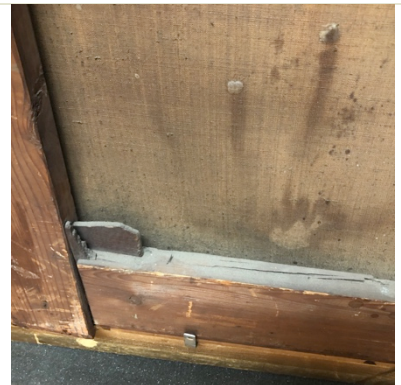
Dépôt de poussière, clé et montant inférieur du châssis cassés
